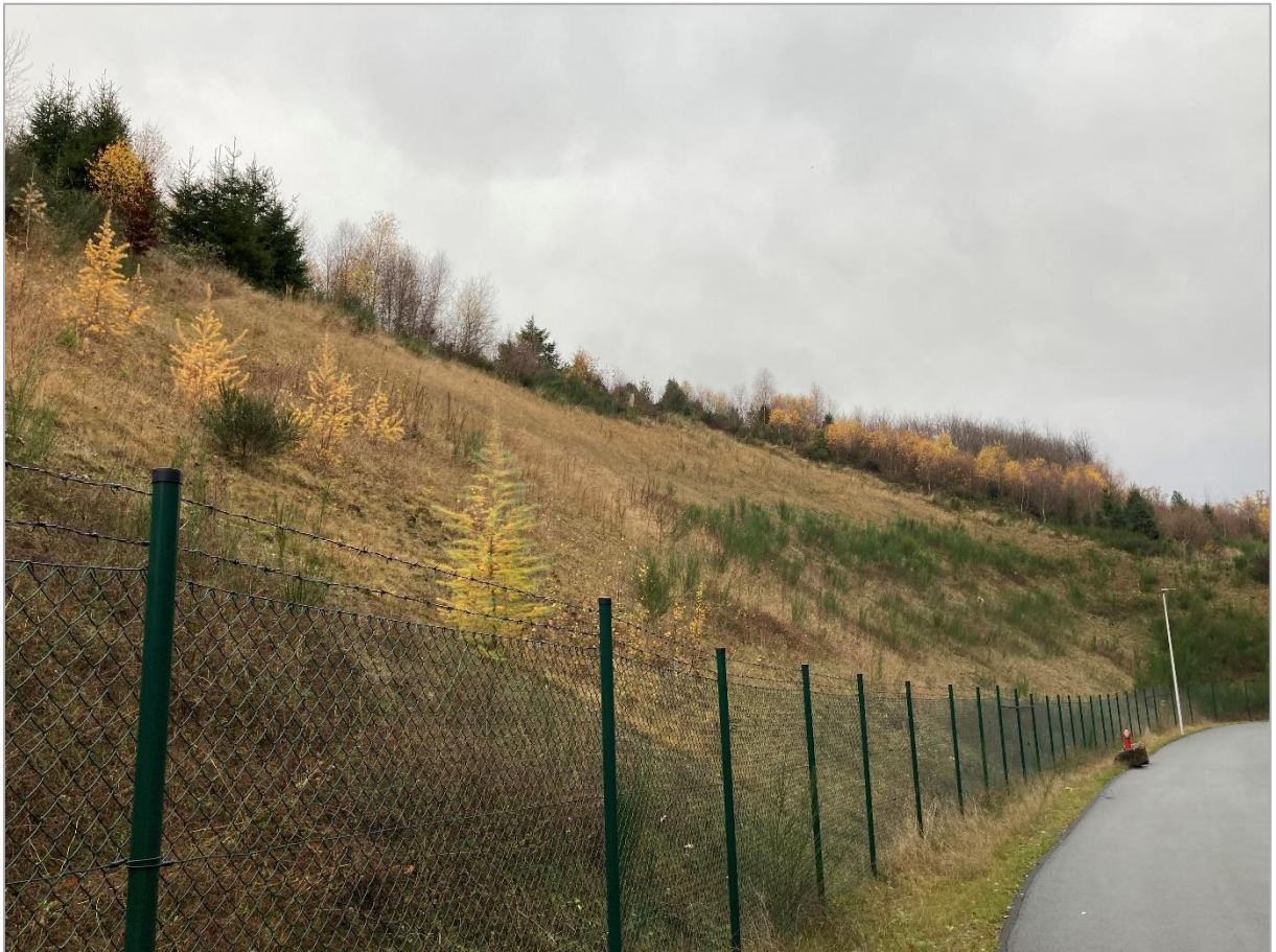
Abb. 5: Im Zuge der Baumaßnahme für die Kombihalle entstandene Böschung am nördlichen Rand des Geltungsbereiches der 4. Änderung und Erweiterung des Bebauungsplans Nr. 49 „An der Wöste“
