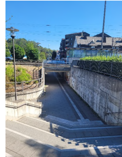
Fuß- und Radunterführung, Kölner Straße
